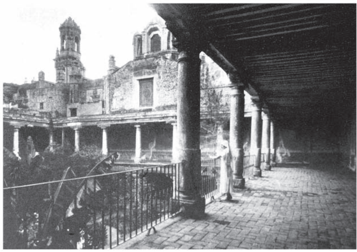
Hospital de San Juan de Dios, interior
