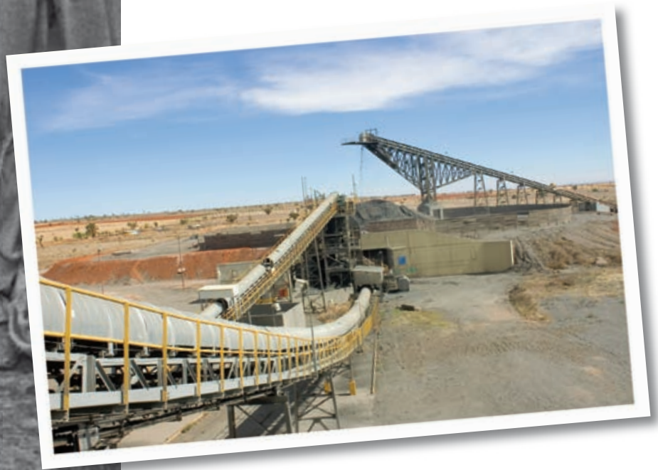
Instalaciones modernas de una mina de zinc en el estado de Zacatecas, México
